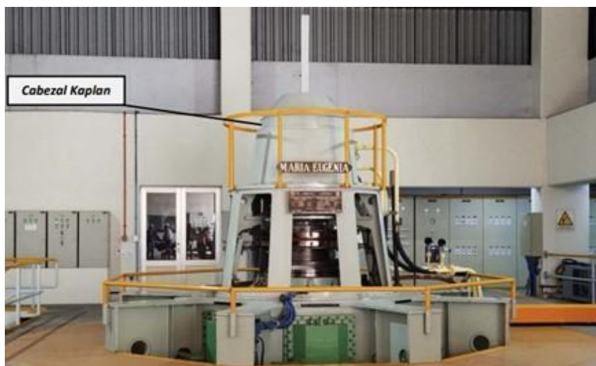
Figura N°12 Generador - Sala de máquinas
